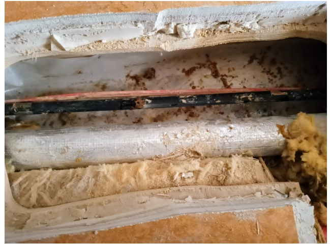
Das Schwarze Rohr musste über mehrere Meter getauscht werden
